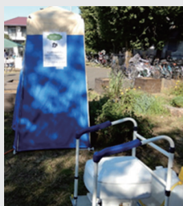
災害用マンホールトイレ
