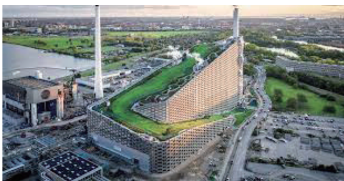
コペンヒルではゴミ焼却の熱を発電に利用している。
